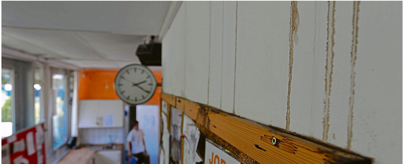
Ein Bild aus vergangenen Zeiten: Das ehemalige Jugendorchester ist die heutige Musikfabrik und lange aus den maroden Realschul-Pavillons ausgezogen. In den Sommerferien erfolgt der Abriss. Foto: ar
